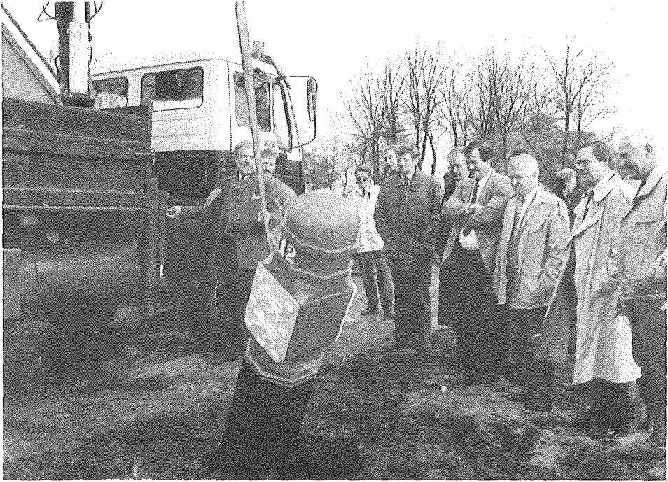
Op de grens van Groningen en Friesland is het werk voor het fietspad begonnen.
